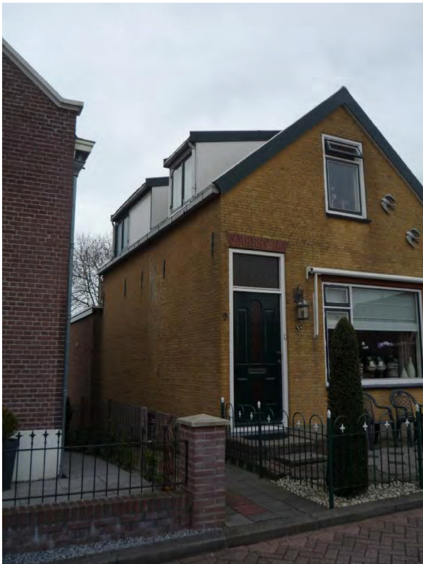
Damstraat 9 linker zijgevel (2)
